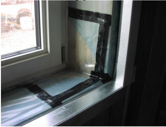
Figur 3 Den invändiga diffusions- eller ångspärren utgörs ofta av en PE-folie som är både diffusionstät och även lufttät. Lufttätheten är dock starkt beroende av montage och arbetsutförande där exempelvis fönsteranslutningar är en viktig detalj.
