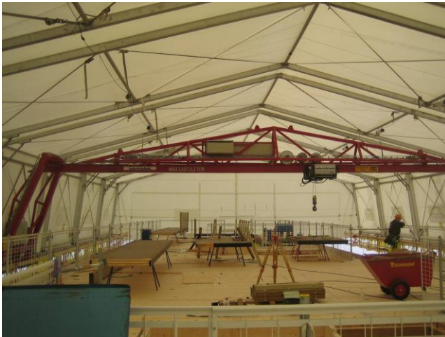
Figur 4 Bilden visar en byggarbetsplats med väderskydd där klimatskalet inte utsätts för nederbörd under byggtiden.
